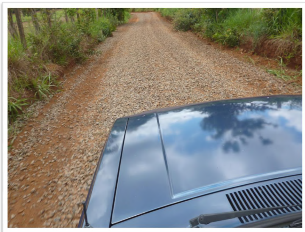
Figura 9: Manutenção em Estradas Rurais
