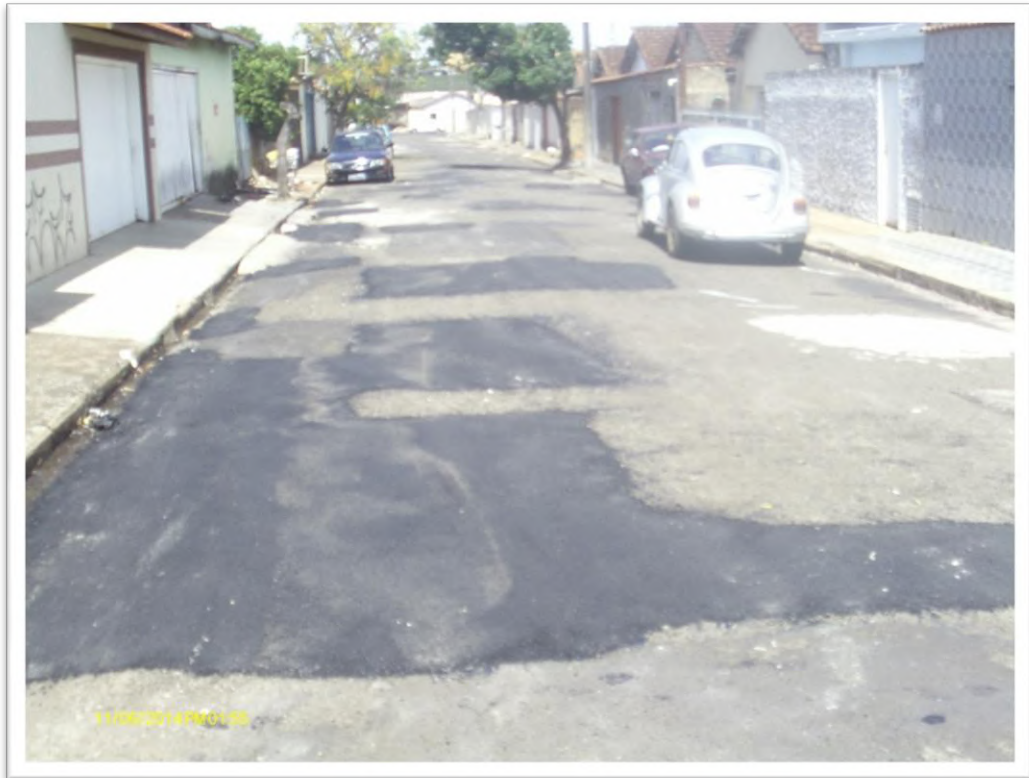
Figura 2: Remendo Asfáltico
