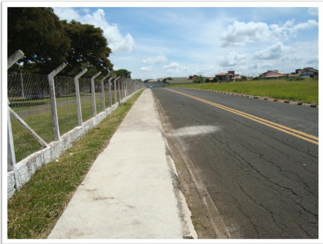
Figura 5: Passeio de Concreto
