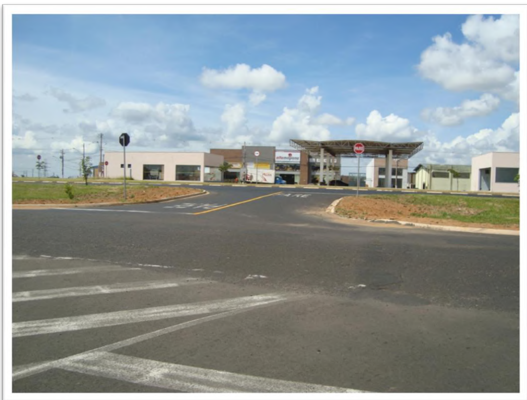
Figura 22: Abertura de Canteiro - Saída para Ibiraci
