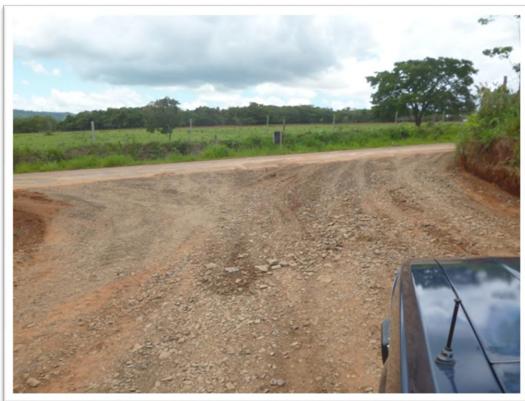
Figura 8: Manutenção em estradas Rurais
