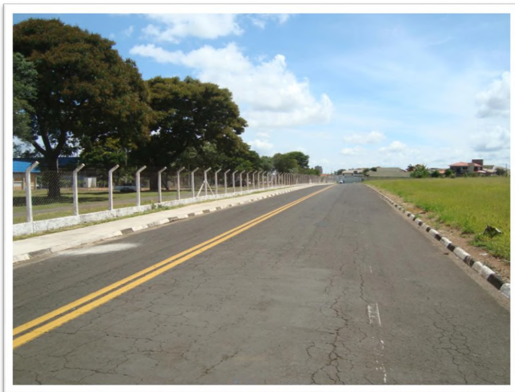
Figura 6: Passeio de concreto
