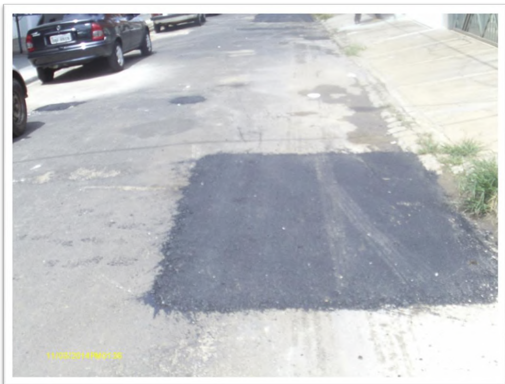
Figura 3: Remendo Asfáltico
