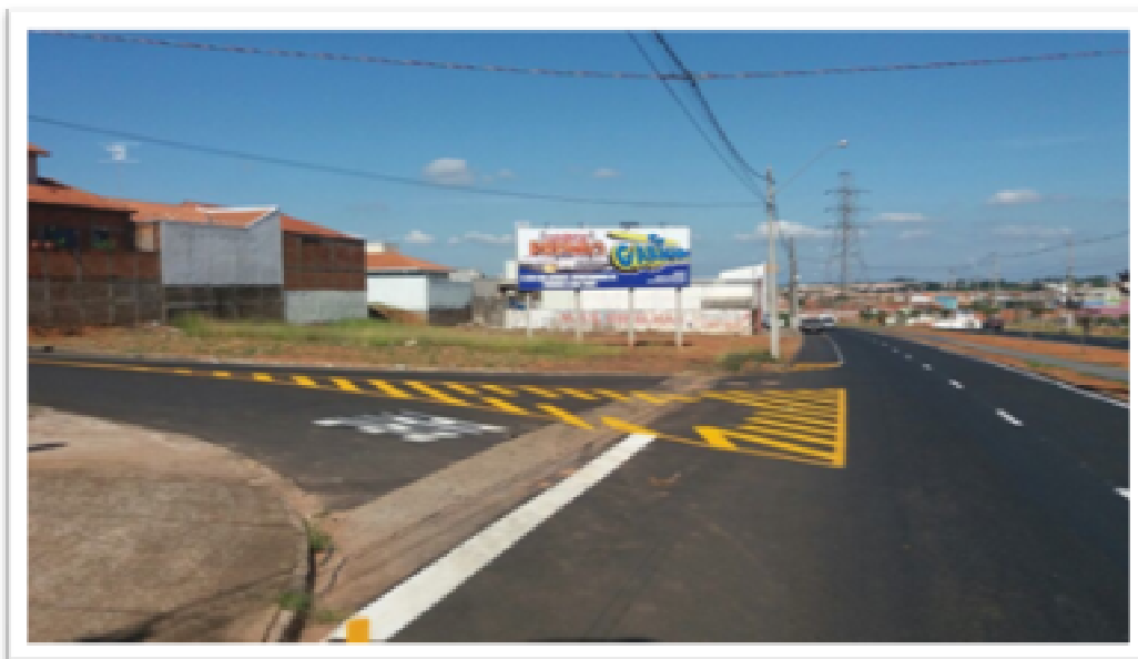
Figura 10: Pintura com tinta viária
