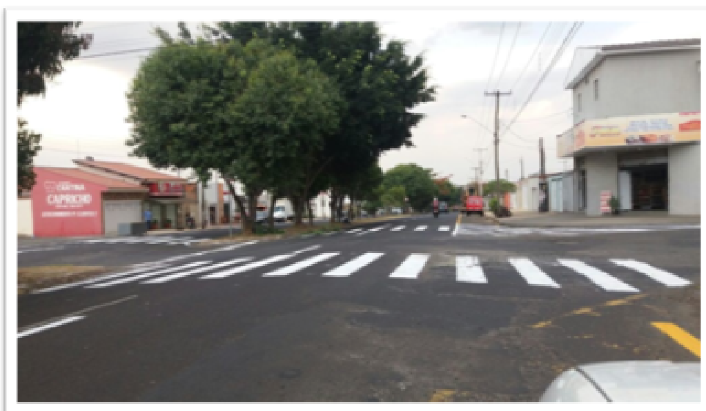
Figura 11: Pintura com tinta viária
