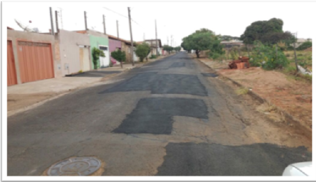
Figura 2: Remendo Asfáltico
