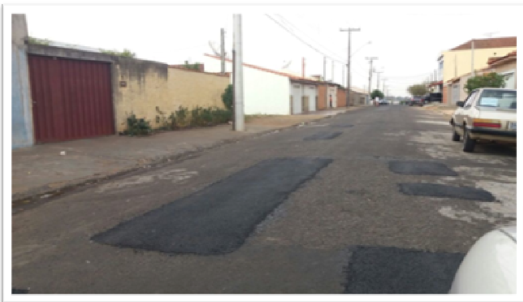
Figura 3: Remendo Asfáltico
