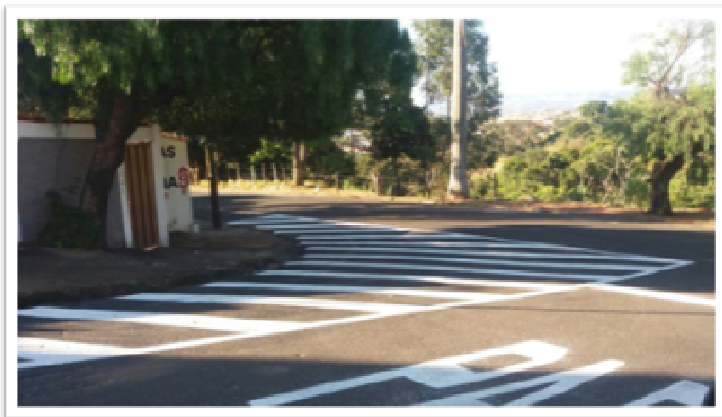
Figura 12 - Pintura com Tinta viária
