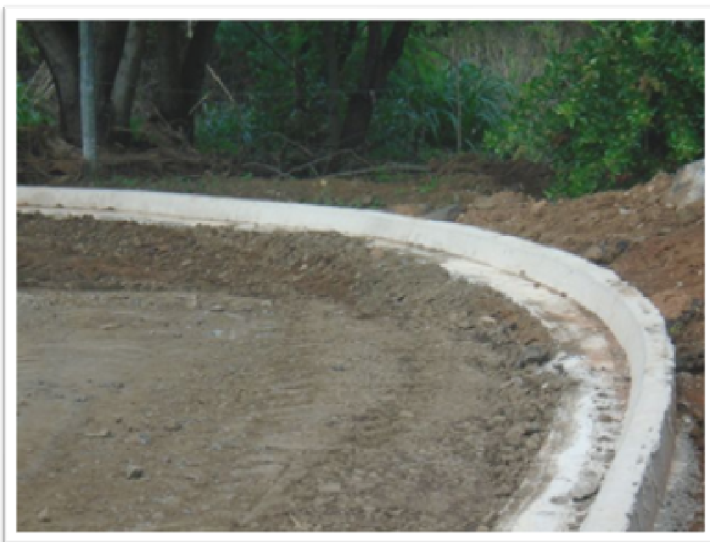
Figura 4: Execução de guia e sarjeta
