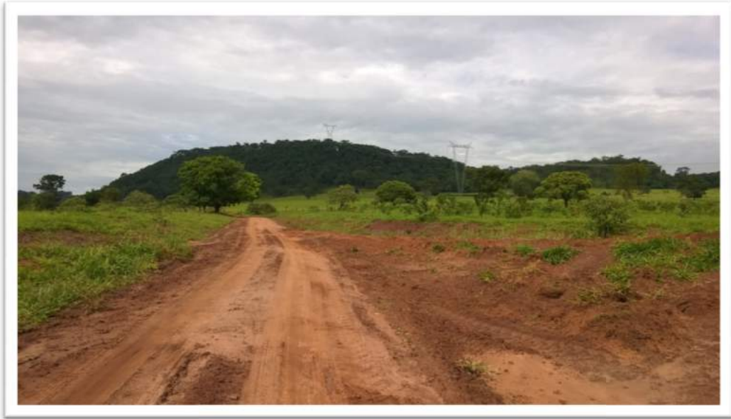
Figura 5: Manutenção em estradas Rurais
