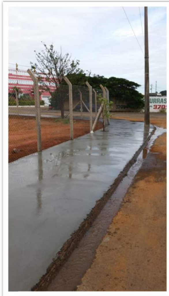
Figura 7: Passeio de Concreto
