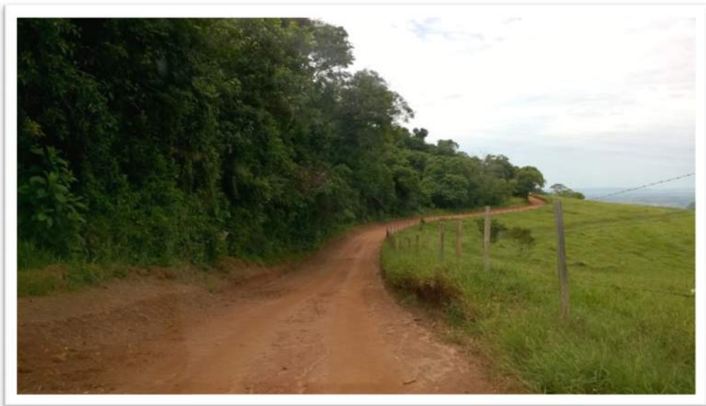
Figura 6: Manutenção em Estradas Rurais
