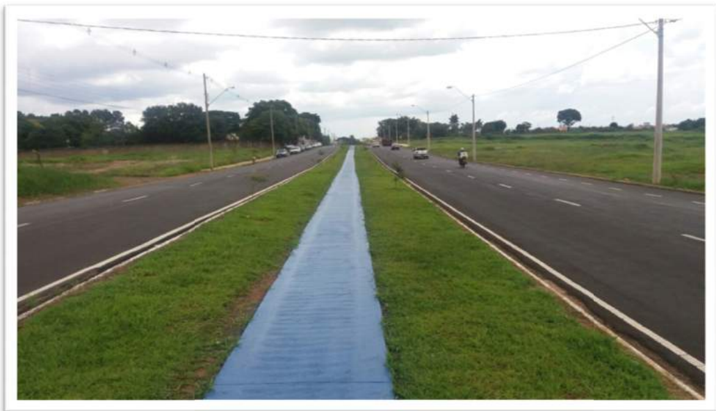
Figura 12 - Pintura com Tinta viária
