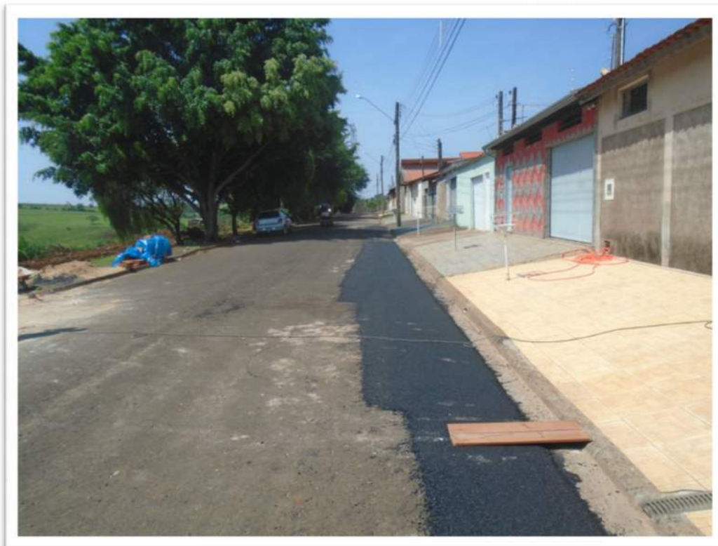
Figura 2: Remendo Asfáltico
