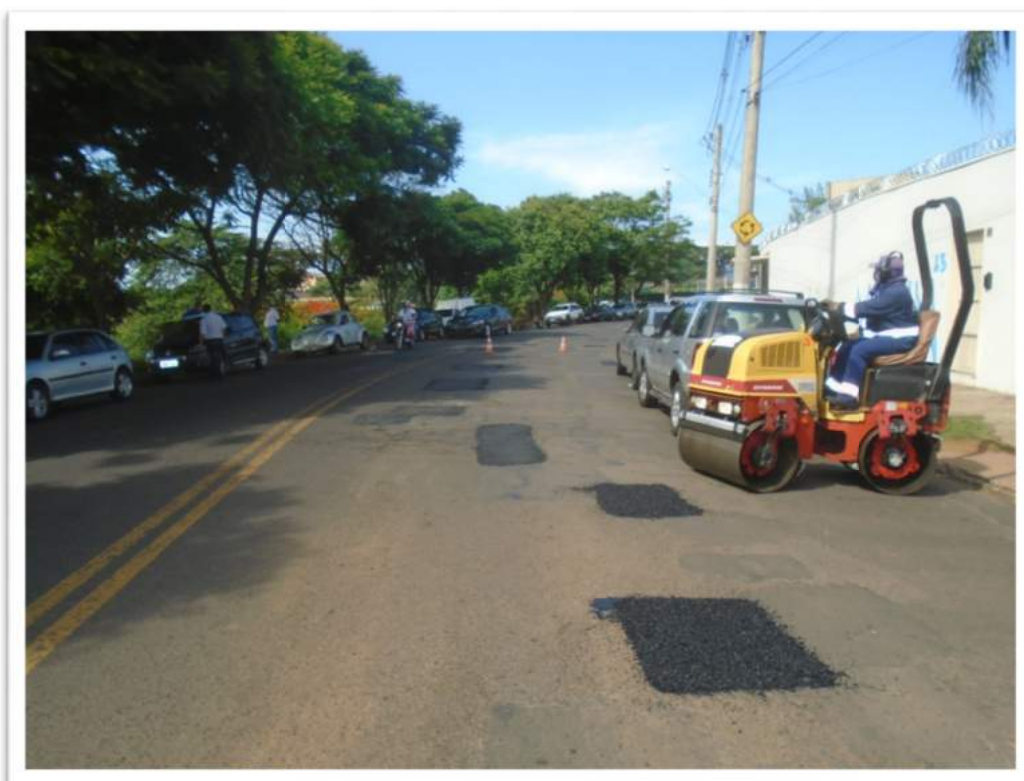
Figura 3: Remendo Asfáltico
