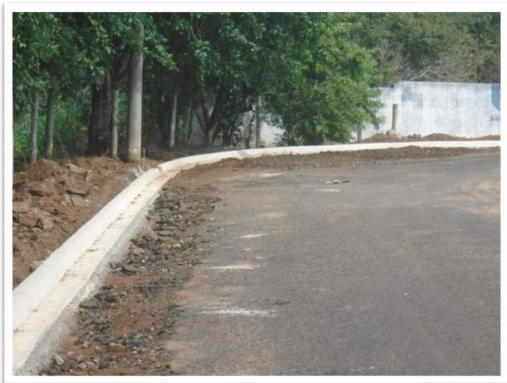
Figura 4: Execução de guia e sarjeta
