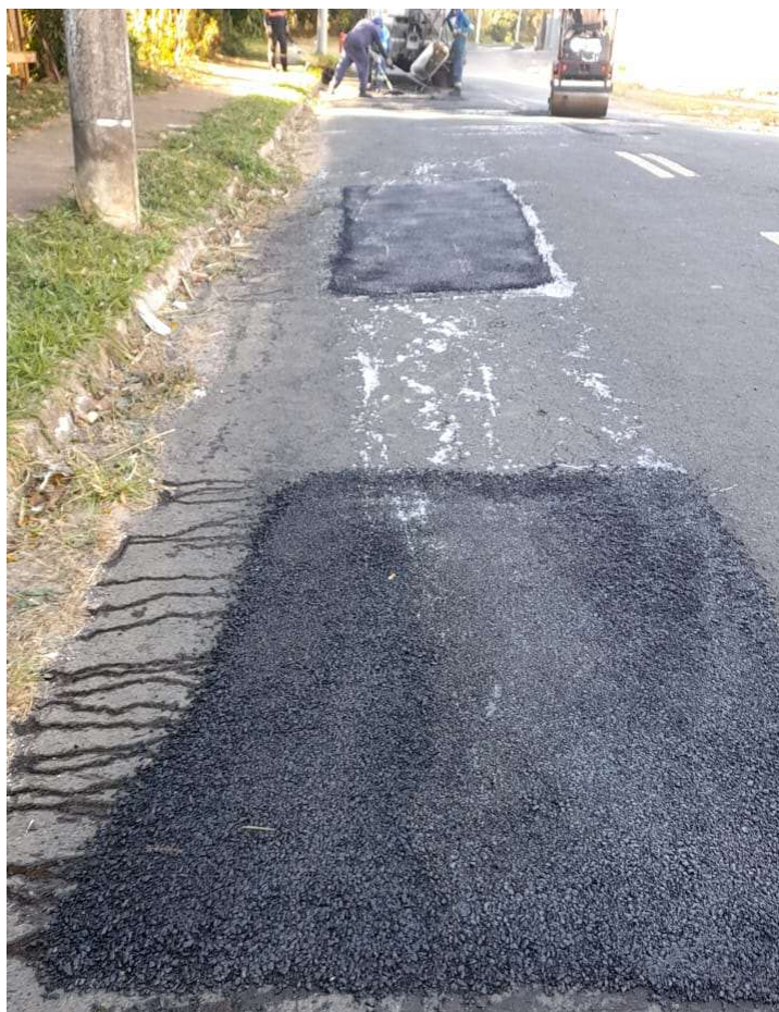
Execução de remendo asfáltico na Rua das Orquídeas
