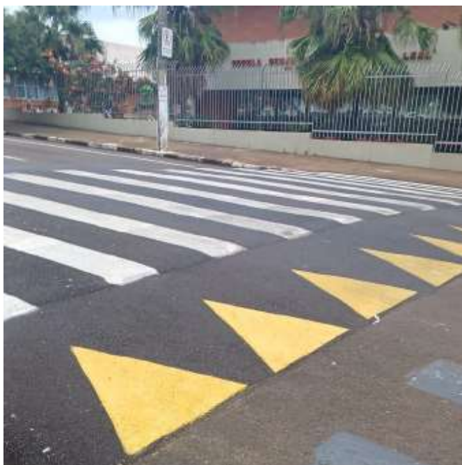
Construção de uma lombofaixa
