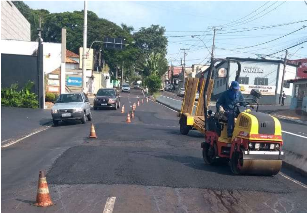
Execução de remendo asfáltico na Av. Champagnat
