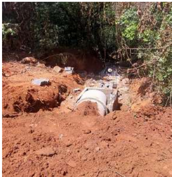
Galeria e poço de visita
