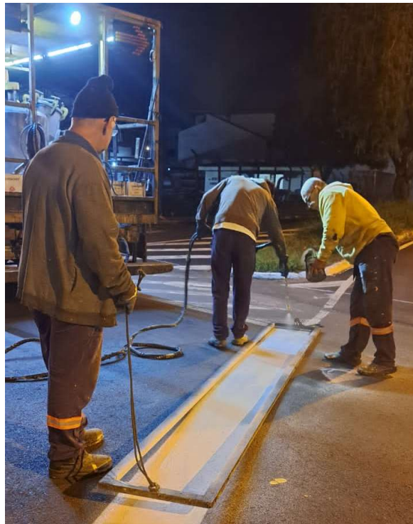
Sinalização viária horizontal – Equipe noturna
