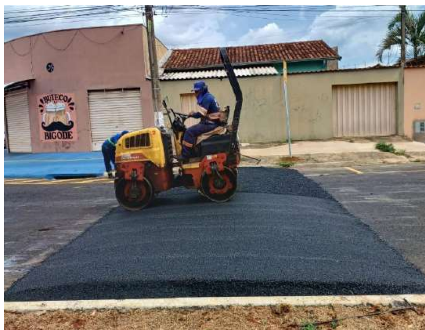
Construção de uma lombada tipo A
