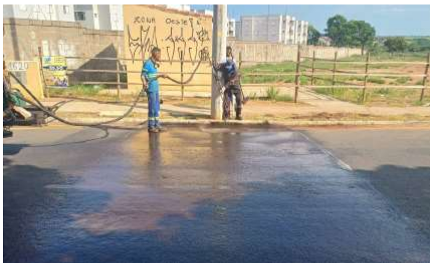
Construção de uma lombada tipo A
