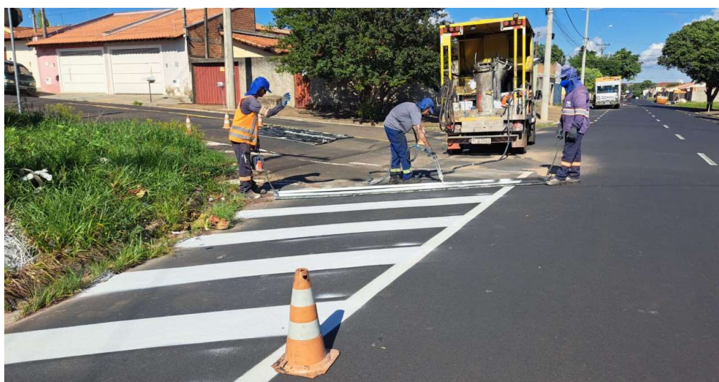
Sinalização viária horizontal – Equipe diurna
