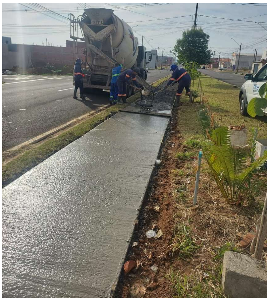
Concretagem de trecho de calçada na Av. São Vicente
