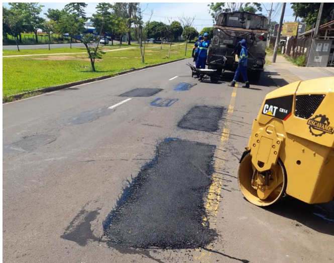
Execução de remendo asfáltico na Av. Dr. Flávio Rocha
